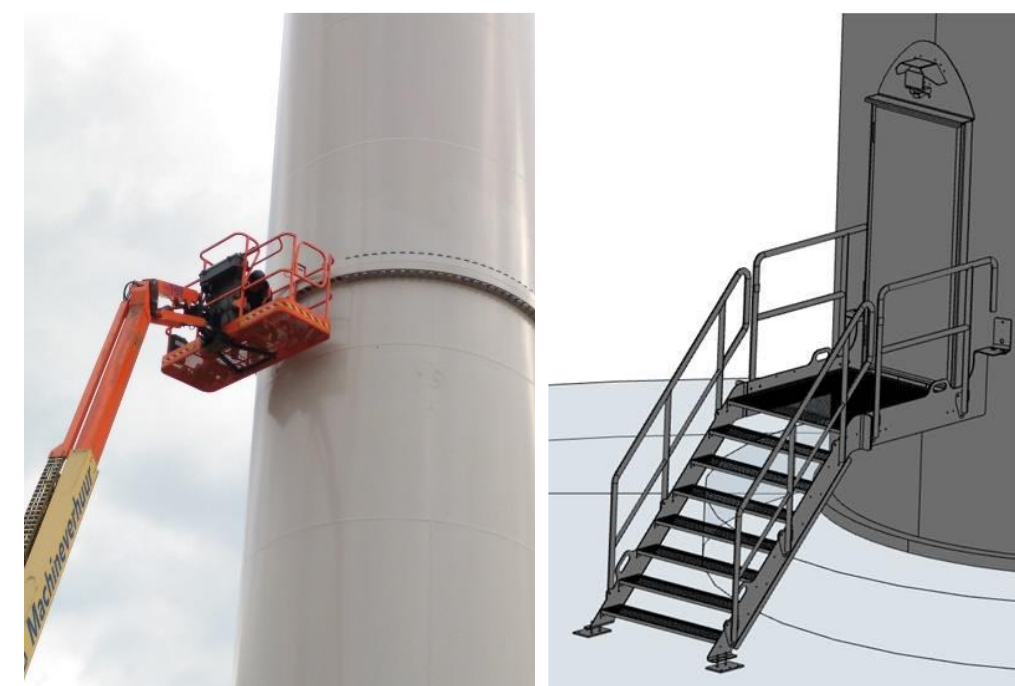
Figure 7 : Mesure ME2 - bride extérieure pouvant servir de perchoir, absent pour le modèle N149TS105 retenu pour le projet (à gauche) et cache et la lampe extérieure ne seront pas installés sur les machines du projet (à droite)(Source : IEA)
